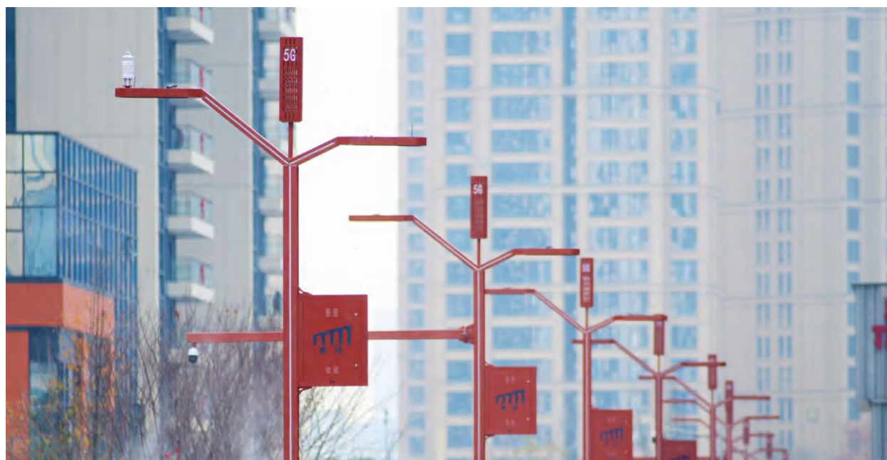
上新智慧多功能杆，构建高效绿色智慧照明体系
