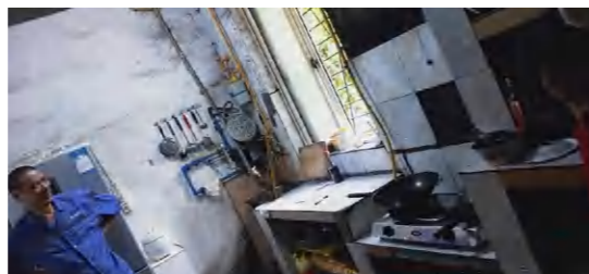
燃气集团对大丰皇花社区每户开展现场踏勘、改造、安装
