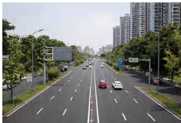
科华南路降噪施工
